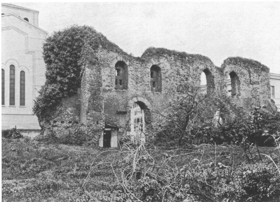
Fig. 5. Resti del lato interno del muro di fondo dell'edificio in *opus incertum* (da GATTI 1934, tav. III).
