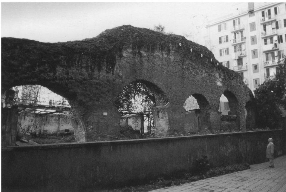
Fig. 3. Gli archi di uno dei muri trasversali dell'edificio in *opus incertum*, da via A. Vespucci n. 49; l'intradosso di archi e volte è costituito da piccoli blocchi regolari di tufo. A destra, Lucos Cozza (foto P. L. Tucci).
